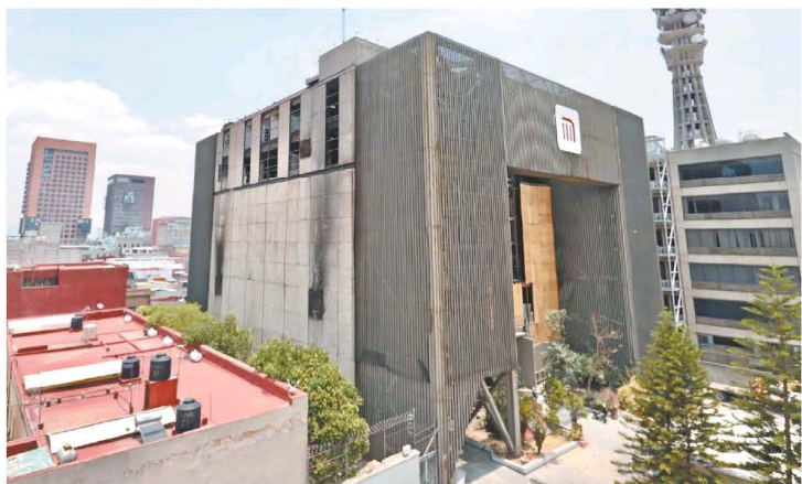
El pasado 9 de enero de 2021, a las 5:20 horas, se incendió el Puesto Central de Control del STC, en el que se realizaban movimientos o itinerarios de seis líneas.
