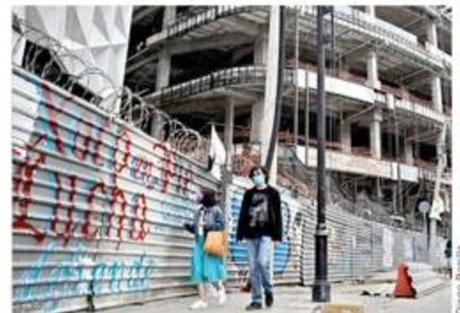
Vecinos se inconformaron en días pasado por la instalación de un tapial en la Calle Real de Mayorazgo.
