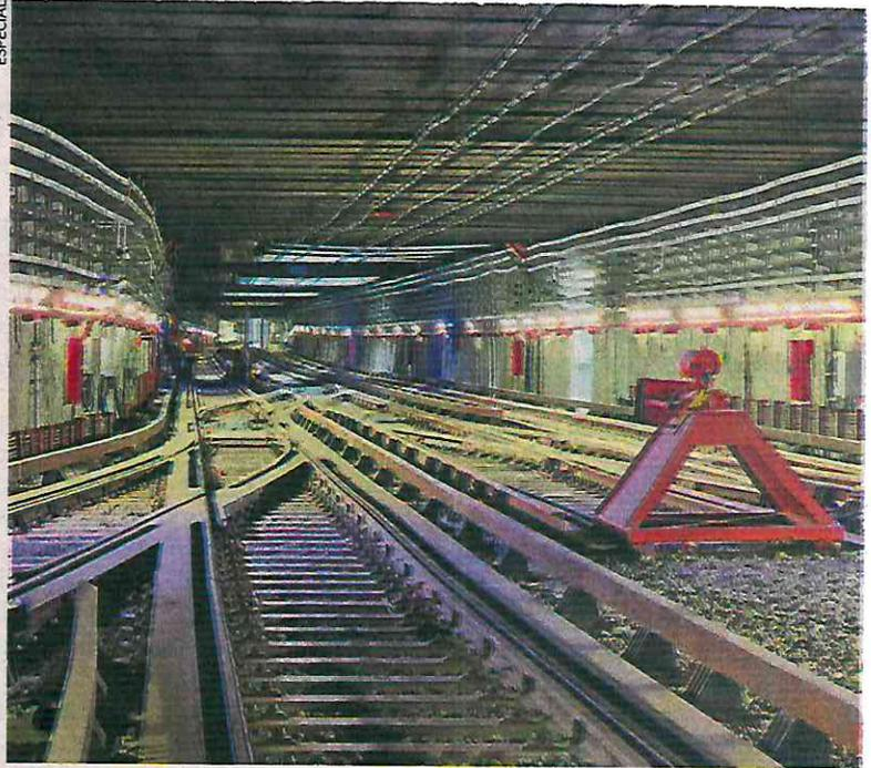
Actualmente, en el tramo de Salto del Agua a Observatorio se realiza el cambio de vías, balasto y atención a filtraciones.
