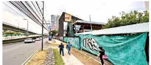
En el proyecto se prevé la construcción de oficinas, hoteles, un centro comercial y más de dos mil viviendas.
