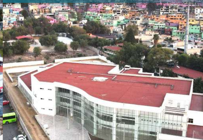
Rehabilitación Hospital La Pastora
