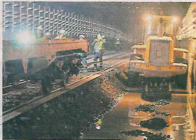
En el primer tramo intervenido de la L1 se trabaja en la colocación de aparatos de vía, informaron autoridades.
