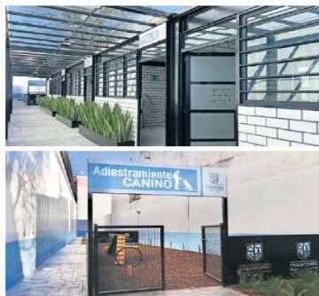
El albergue se encuentra ubicado en el Deportivo Morelos, en Tepito.
