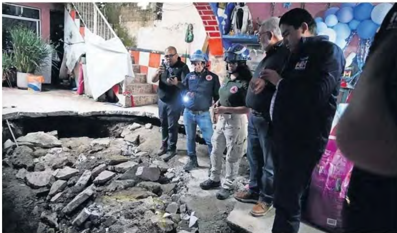
Autoridades del gobierno capitalino y la alcaldía detallaron que el hundimiento fue provocado por la ruptura de una tubería.
