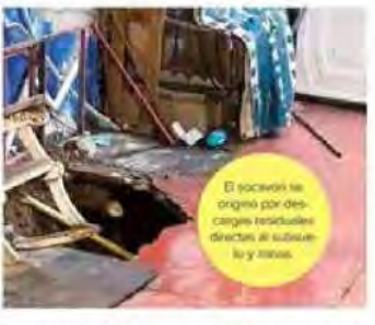
El socavón se originó por descargas residuales directas al subsuelo, que reblandecieron el terreno, aunadas a una edificación sin cimientos y posibles oquedades o minas en la zona.
