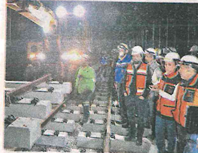
La funcionaria también mostró el proceso de soldadura para unir los tramos de vía de 18 metros que conforman los rieles /CORTESÍA GCDMX
