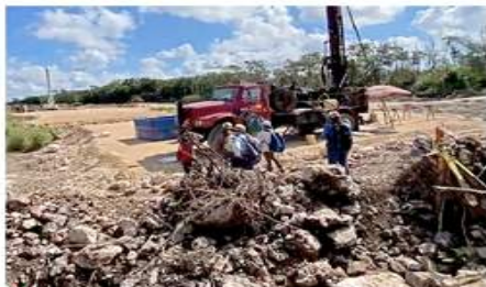
Barrenos usados en las obras del Tramo 5 del Tren Maya.
