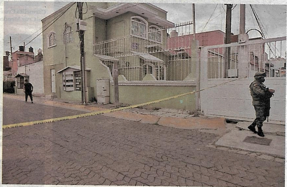
Una detonación ocasionó daños a una vivienda en Real de Guadalupe. ANDRÉS LOBATO
