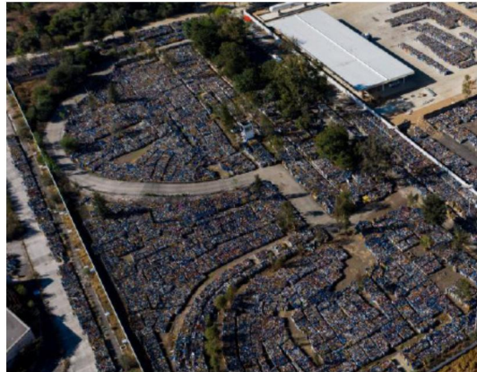
La ex Refinería 18 Marzo en la alcaldía Miguel Hidalgo se ha convertido en un almacén de miles de tanques de gas defectuosos.
