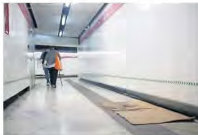
En el pasillo hacia el andén en la estación Sevilla también fue colocado un cartón para evitar que los usuarios sufrieran algún accidente.
