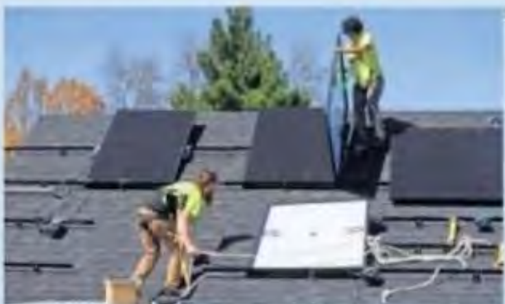
Theodore Tanczuk, a la izquierda, y Brayan Santos, a la derecha, del instalador solar YellowLite, colocan paneles en una casa en Ohio.
