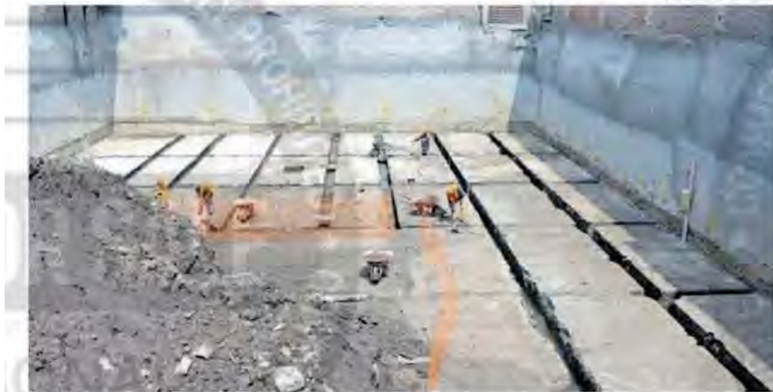
En el número 193 de la calle Lago Peypus, en la Miguel Hidalgo, se construyen 89 departamentos a bajo costo
