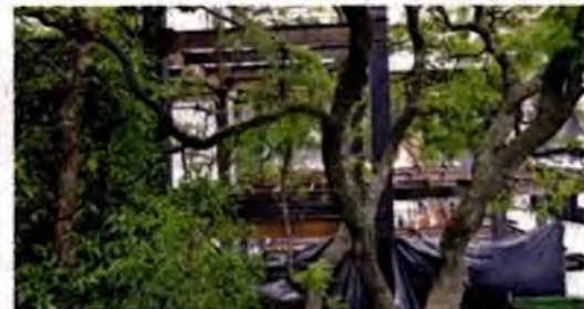
Los ejemplares al interior del predio fueron afectados por la estructura que instaló la desarrolladora.
