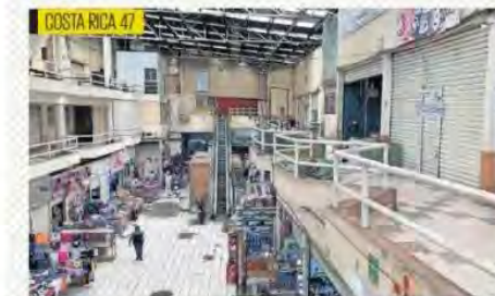
Esta plaza cuenta con tres pisos, pero sólo en la planta baja hay locales abiertos en los que se vende ropa, tenis, chanchas y hasta comida.
