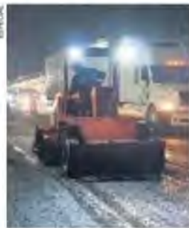
Para el bacheo se usarán 7 mil toneladas de mezcla asfáltica.
