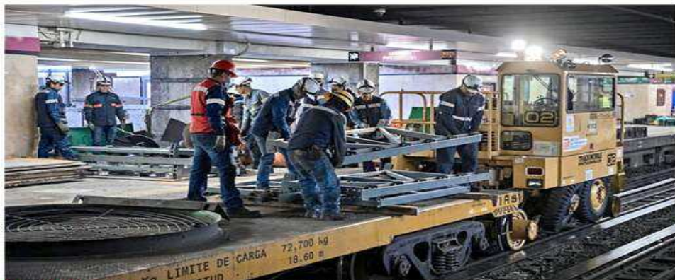
MANOS A LA OBRA. El túnel a modernizar comprende 9 estaciones y alcanza los 9 kilómetros.
