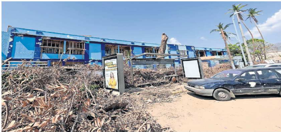
Plantales públicos de educación permanecen cerrados y con daños; los escombros y basura no han sido recogidos.
