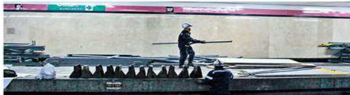
Se retirarán vías, barras guía, paneles de vía, rieles y alrededor de 20 mil toneladas de balasto.
