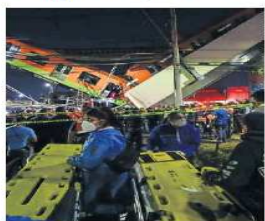
El desplome del tramo elevado de la L12 dejó 26 muertos.
