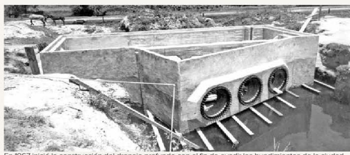
En 1967 inició la construcción del drenaje profundo con el fin de evadir los hundimientos de la ciudad.
