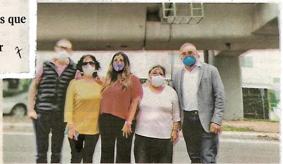
Constatan diputados locales del PAN que el puente Muyuguarda está en riesgo de sufrir un colapso /FOTO: CORTESÍA
