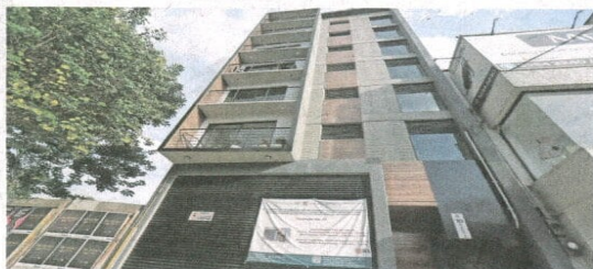
Do departamentos del edificio ubicado en la calle de Coahuila número 10 de la colonia Roma Norte, en Cuauhtémoc, fueron subastados.
