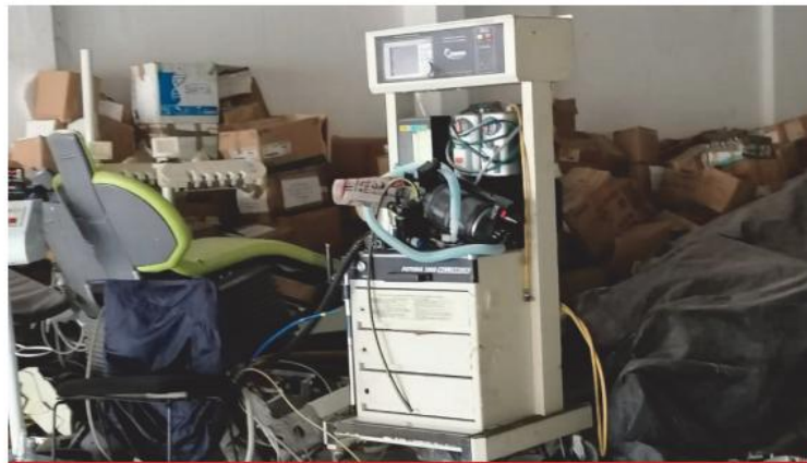
El centro integrador de Boca del Río es un inmueble en el abandono, donde dominan basura y suciedad, sin servicios básicos como agua y sanitario funcional y lo quieren convertir en centro de vacunación.
