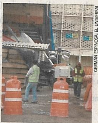
La tercera etapa de reconstrucción lleva 40% de avance.
