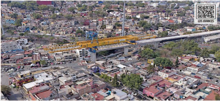
En el tramo que va de la Presa Tacubaya a la estación Observatorio, un tramo de 500 metros aún carece de columnas.
