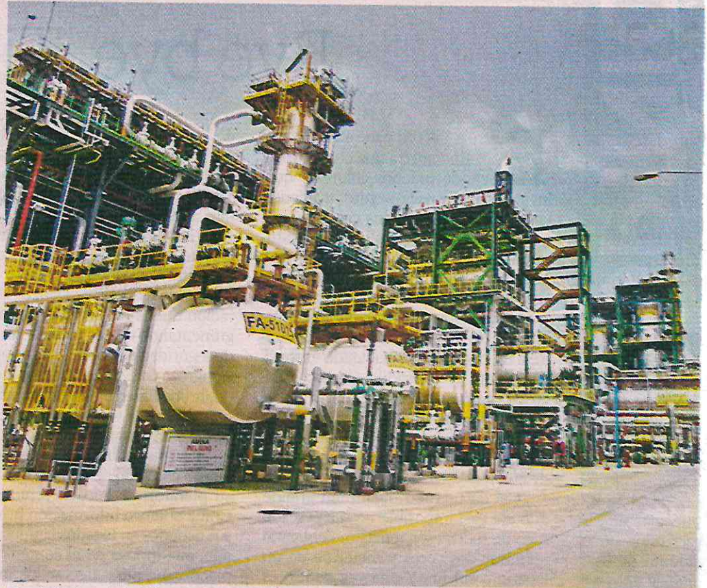
■ Recipientes de la Planta Hidrodesulfuradora de diésel de la refinería de Dos Bocas, donde se realiza el proceso para retirar el azufre separado del diésel y llevarlo a recuperación.
