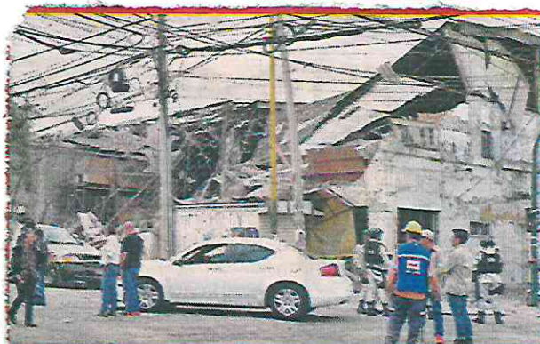
■ Lo que fue una casa acabó reducida a escombros.
