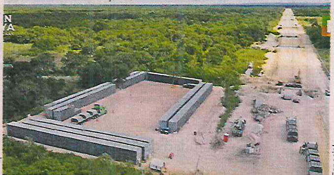
En la comunidad de El Triunfo, Tabasco, se instaló una fábrica china que surtiría de rieles al Tramo 1 del Tren.
