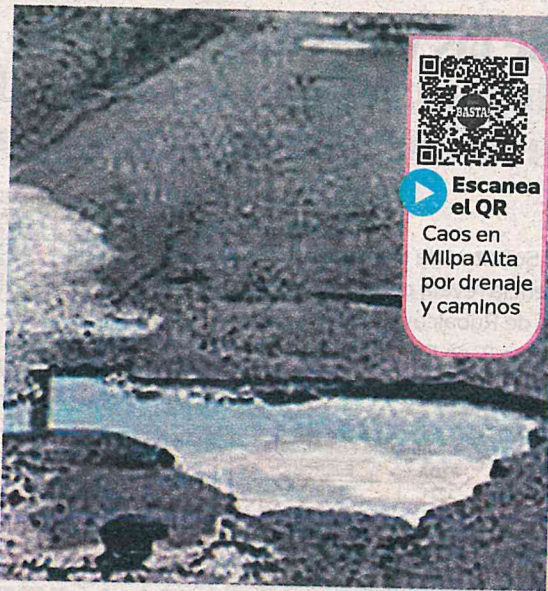
Alcaldía con infraestructura deficiente
